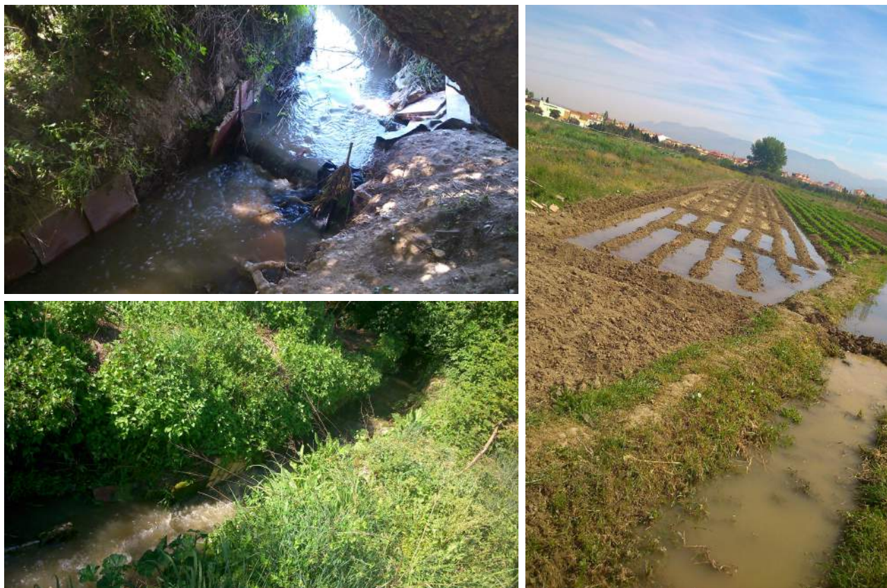
Fotografías 12, 13 y 14. Canalización del agua de riego hacia la parcela. Tomadas el 24 de Abril.
